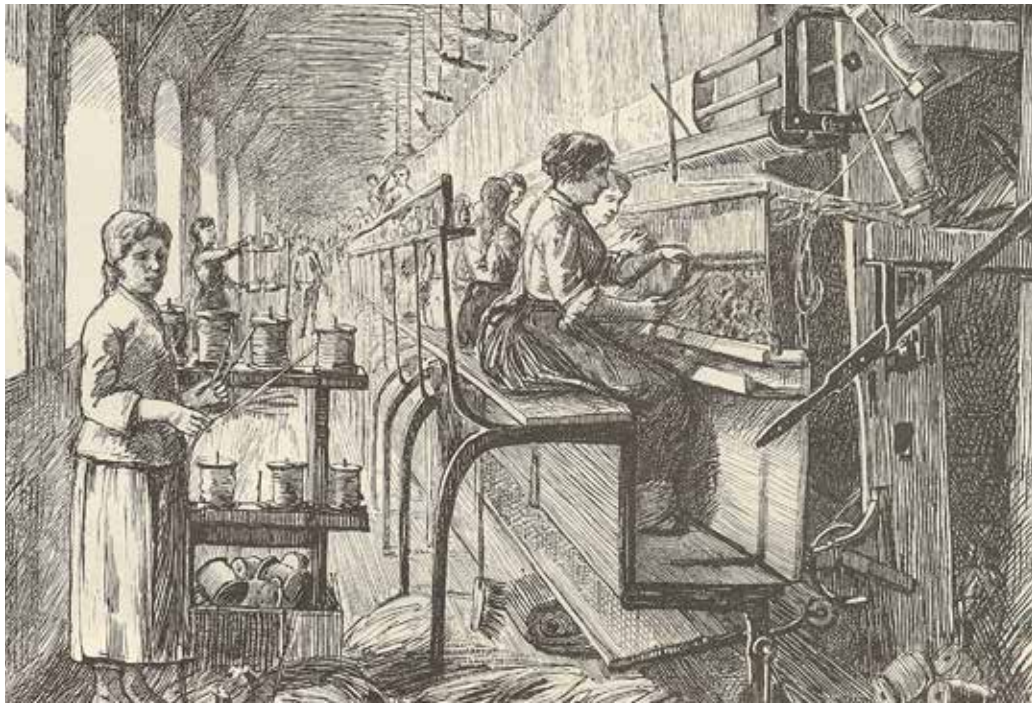
1852 wurden die ersten mechanischen Webstühle in der Teppichfabrik Philipp Haas & Söhne in Ebergassing aufgestellt. Arbeiterinnen beim Teppichknüpfen (um 1895)
